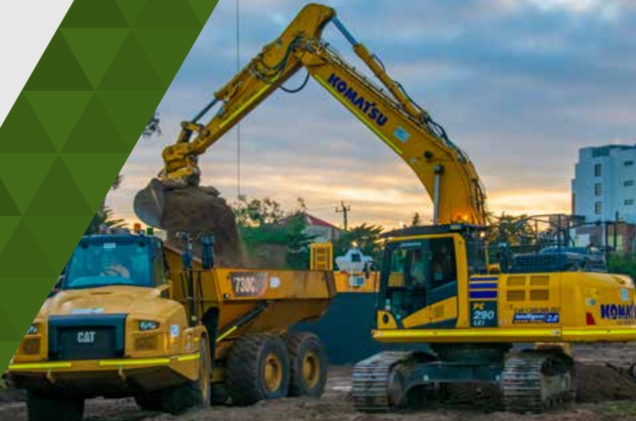
工作人员一直在准备施工场地。
